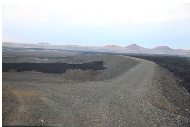
図4 土塁の例(右側の黒い部分が溶岩流)
