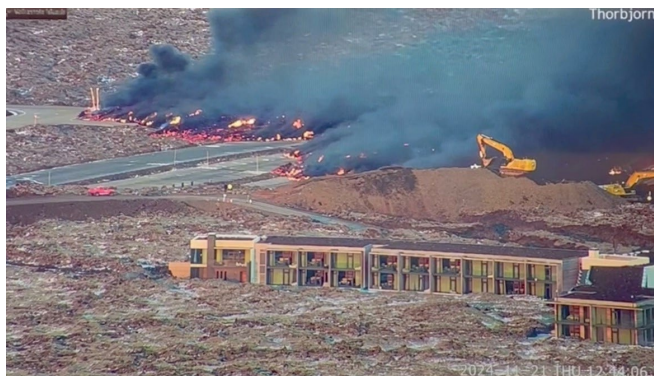
図3 アイスランド・レイキャネス半島における溶岩流制御の土塁構築。噴火開始後半日でブルーラグーン駐車場に迫る溶岩に土塁を嵩上げ中。2024年11月20日昼のリアルタイムカメラ画像(アイスランド気象庁で撮影)
