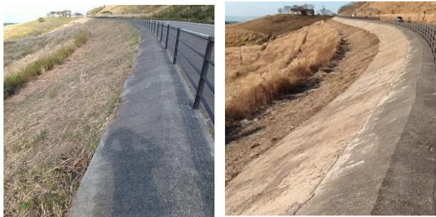
写真-1 防草工（左・着工前、右・竣工後）
