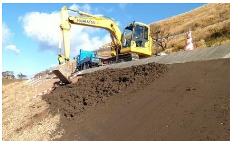
写真-2 防草工ソイルセメント施工状況
