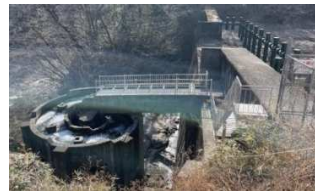
図-2 上木 瀬砂 堰堤
