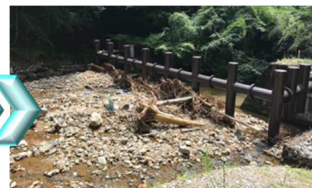
図-4 流木捕捉後
