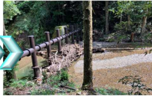
図-8 流木捕捉後
