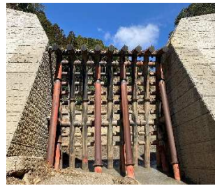
図-10 除石後の堰堤状況
