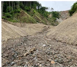
図-6 除石後の状況（上流側）
