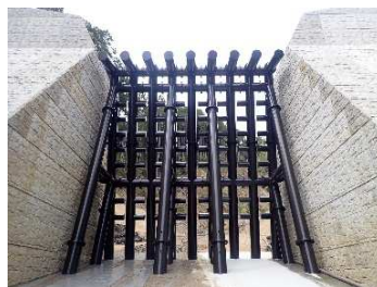
図-2 堰堤設置状況
