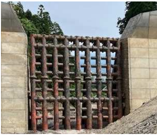
図-7 除石後の堰堤状況
