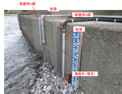
図-6 配管部の保護
