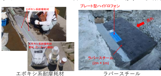
図-4 耐摩耗対策の事例
