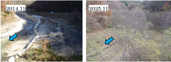
図4 堆砂敷の植生状況の変化(堰堤左岸袖部より撮影)
