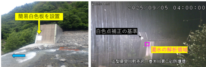
図-2 春木川第二砂防堰堤の簡易白色板設置状況と解析領域
