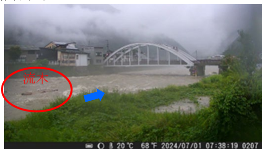
図1 令和6年7月時の流木流下状況写真
