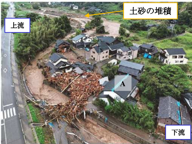
図2 (a) 輪島市塚田町の橋梁周辺の被災後の様子 1)
