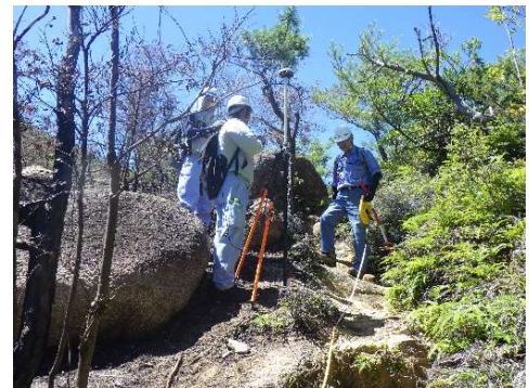
写真-2 VRS測量による被災範囲の計測
