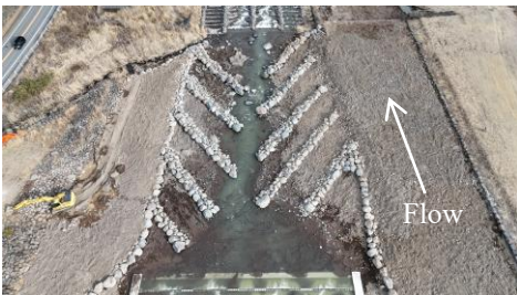
図-5 ドローンにより撮影されたバープ工の様子
