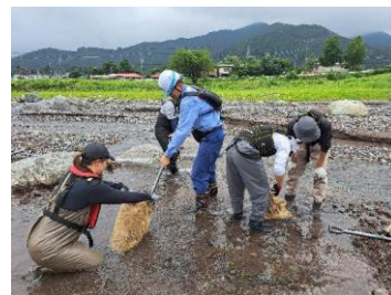
図-6 地域のボランティアによるバープ工の維持作業の様子。麻袋に土砂を詰めて巨礫の間に設置する。
