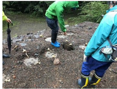
堆積土砂にセメントを流しこんで固めている様子
