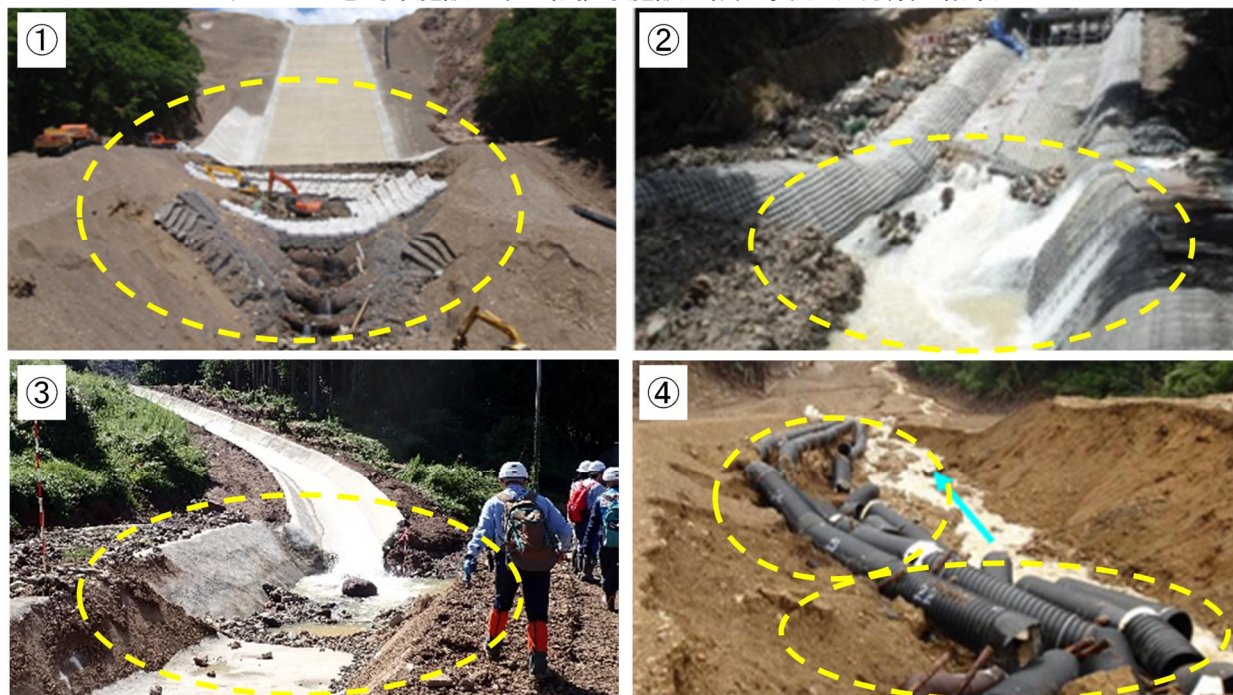
図-1 応急対策施設のうち仮排水施設の被災事例 (4分類の結果)
