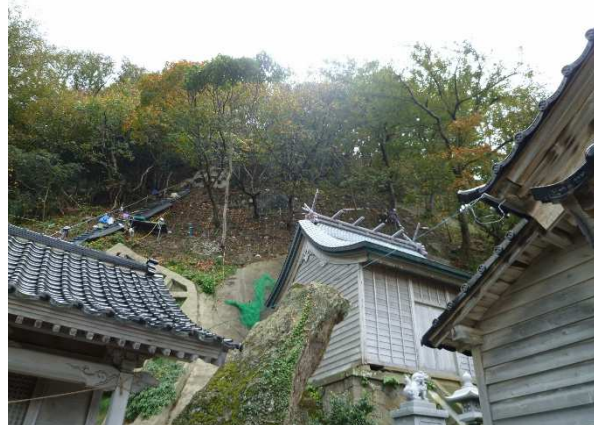
図2 施工時の状況(2012年)
