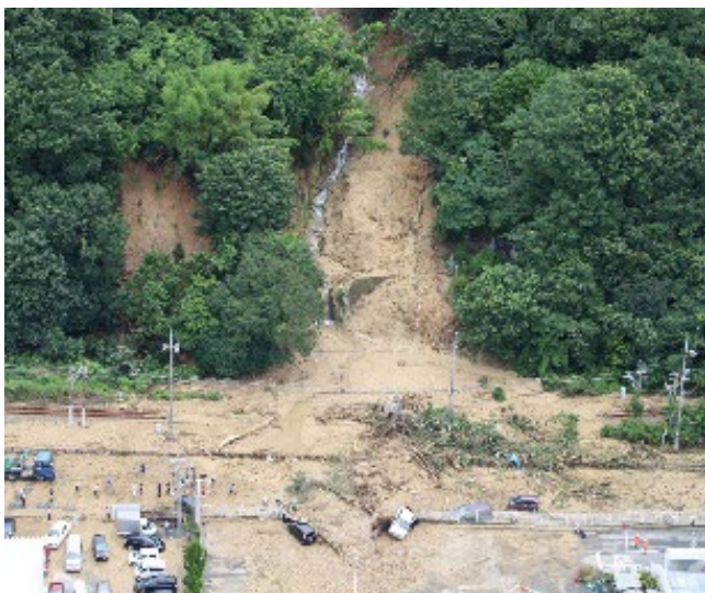
図1 流動化した土砂が線路に到達した事例
