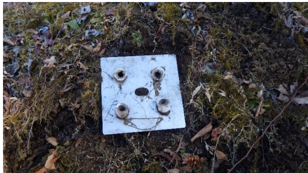
図-2 斜面Bの崩壊と鉄根打設状況
