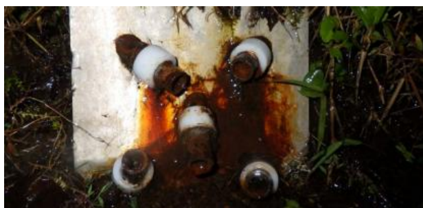
図-2 斜面Cの鉄根の打設及び排水
