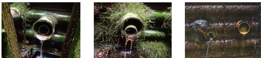
閉塞レベル1(閉塞なし)の例 閉塞レベル2(閉塞25%未満)の例 閉塞レベル3(閉塞25%以上)の例
