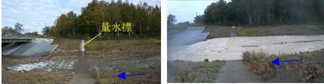
写真-2 調査期間中の河道(左:平時,右:最大出水時)
