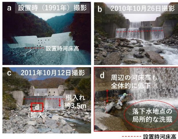
写真1 湯ノ入沢砂防堰堤の経年変化
