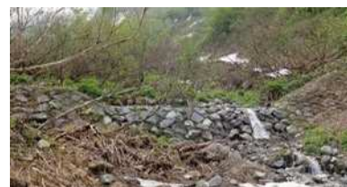
写真-1 県営施設（空石積堰堤）
