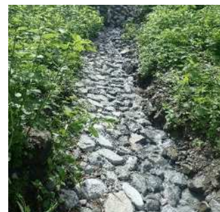
写真-2 県営施設（石張水路工）
