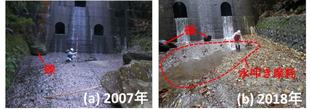
写真 3 a, b 高智谷堰堤における 2007, 2018 年度点検時の水叩きの様子
