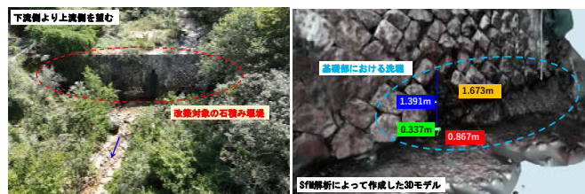
写真-1 UAVの活用 (左: 斜め写真, 右: 3Dモデル)
