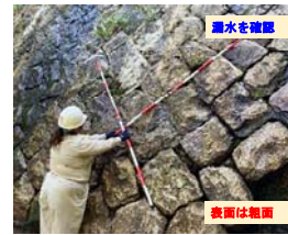
写真-2 石積み堰堤下流面
