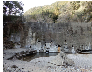
図1 富田川砂防堰堤
