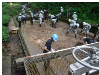
図2 排砂作業の様子
