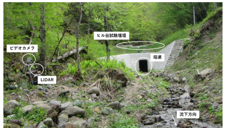
図 1 ヒル谷試験堰堤下流における観測状況
