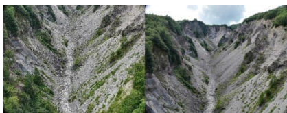
図 2 下堀沢第 2 号砂防堰堤の撮影例
