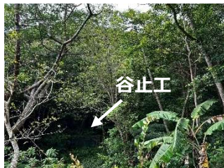
写真2 谷止工の状況
