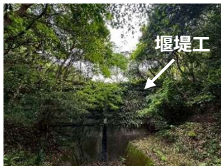
写真1 堰堤工の状況
