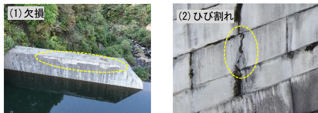
図-1 UAV 点検で判別可能であった変状の例
