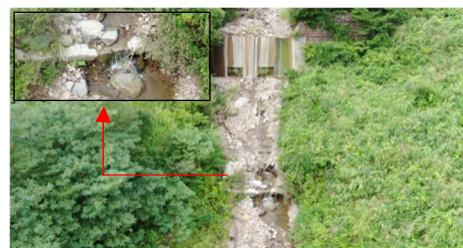
図9 護岸基礎部の洗堀(夏季)
