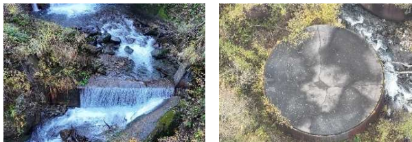
図5 土沢川における点検写真(左:近景, 右:遠景)
