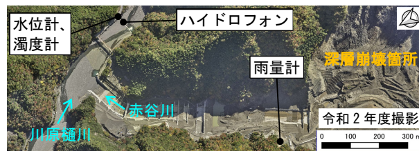
図1 赤谷地区の流砂水文観測機器の配置状況
