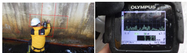
写真-1 超音波被膜計を用いた塗装厚の計測状況
