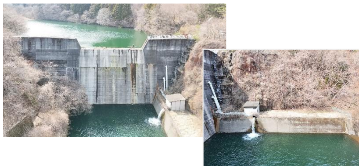
図 1 堰堤概況（左：正面、右：左岸側壁護岸）
