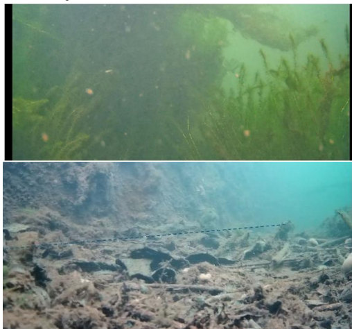
図5 水中ドローン撮影結果 (上：水草の繁茂、下：水叩き部)
