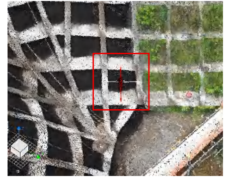
図-1 枠中心間隔の3次元計測状況 (CASE1 No.4)
