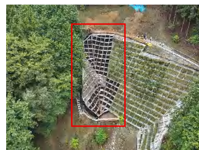
写真-1 現場全景
