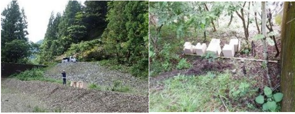
写真3 ダミー変状設置状況(左:植生無、右:植生有)
