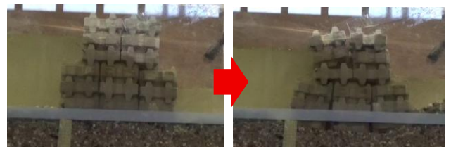
図-7 Type1の基礎洗掘・沈下の様子
