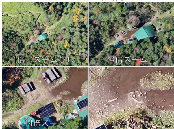
図 3 構造物の撮影例 (焼岳小屋付近)
