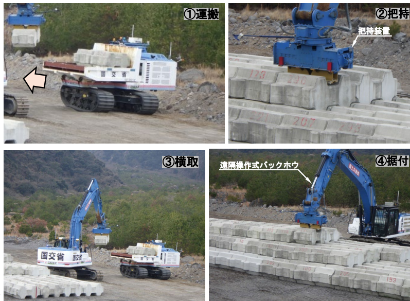
図2 無人化施工によるコンクリートブロック据付作業風景 表1 ヒアリング結果の一覧
