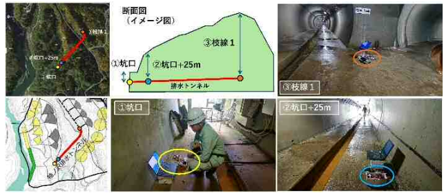
図-3 排水トンネルでの検出器の設置状況
