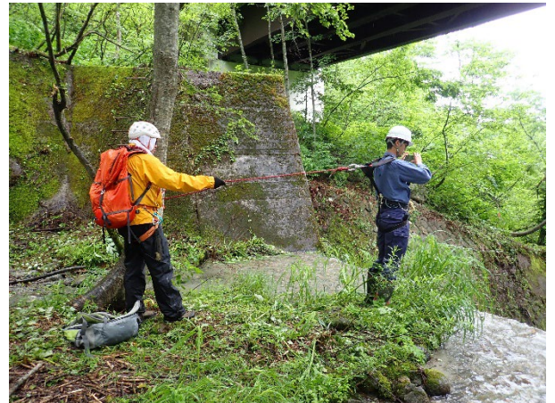
図-4 砂防堰堤付近の落下防止対策
