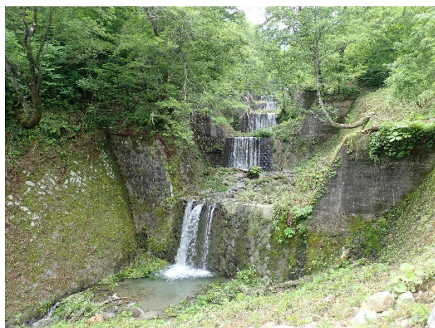
図-2 泥谷砂防堰堤群の現況 (伐採等作業後の第九号砂防堰堤から上流側の状況)
