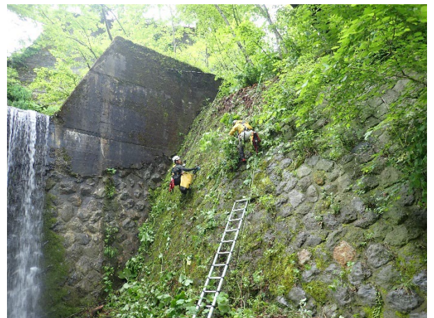
図-5 側壁護岸における高所作業の状況
