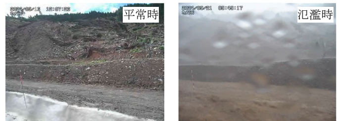
写真1 監視カメラ6での被災状況比較写真
