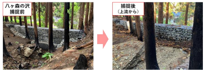
図9 土砂捕捉の様子（八ヶ森の沢）
