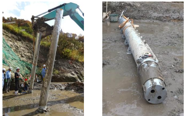
図-4.1 支柱引抜き試験実施状況
