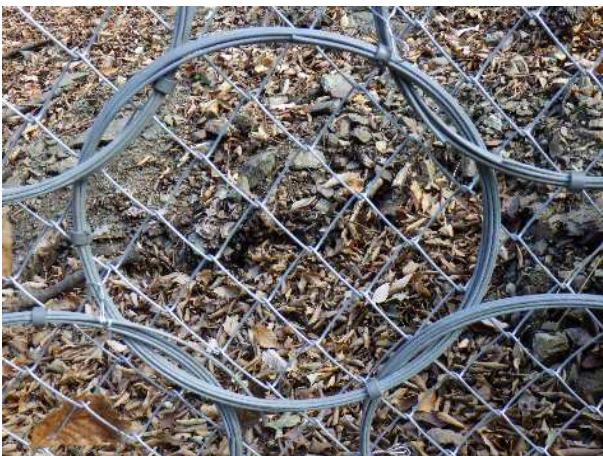
図 3 2025 年設置のリングネット状況
