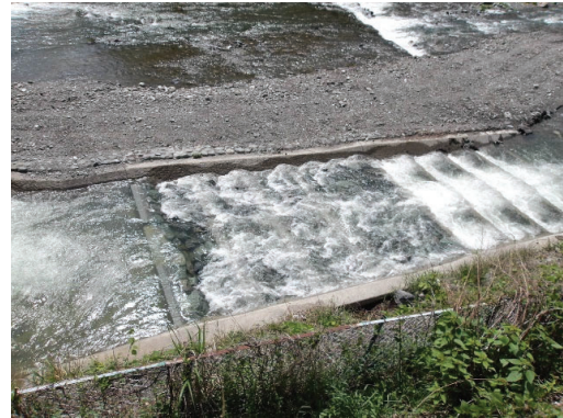
写真3 魚道上流部に試験的に設置した石組み
