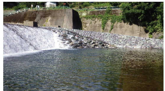
写真4 2018年3月時点の魚道整備された状態
