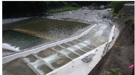
写真2 2017年5月時点の魚道整備された状態
