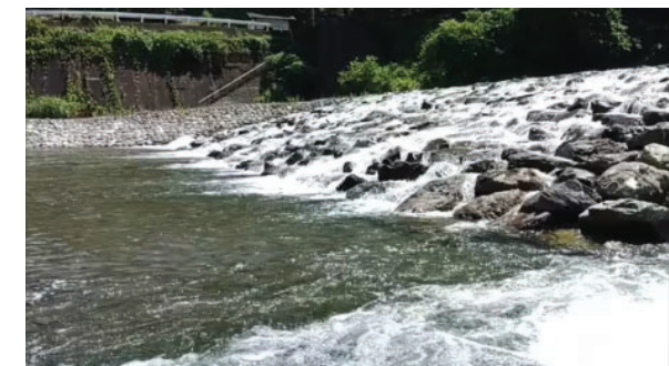
写真8 石組み斜路の流れを左岸側から見た状況
