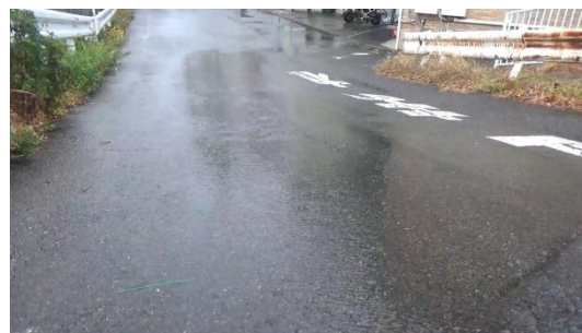
図2 表面流が発生しているアスファルト面
