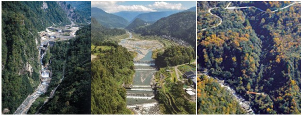
白岩砂防堰堤 本宮砂防堰堤 泥谷砂防堰堤群
