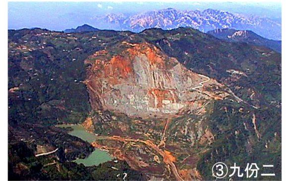
図-5 台湾集集地震にて発生した九份二崩壊
