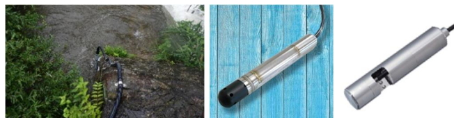
図3 左: 機器設置状況 中: 水位計 右: 濁度計
