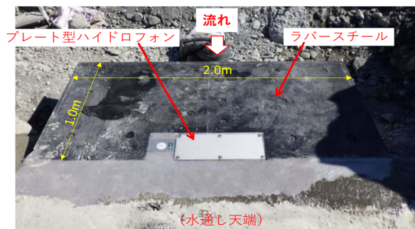
図-3 ラバースチールによる耐摩耗対策(生田)
