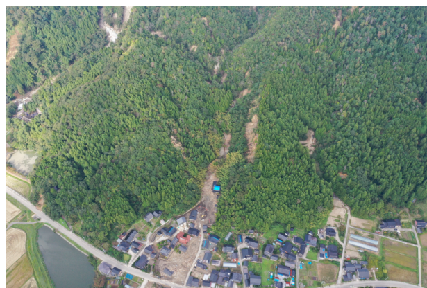
写真 2.3 南時国地区の全景（流木被害溪流）
