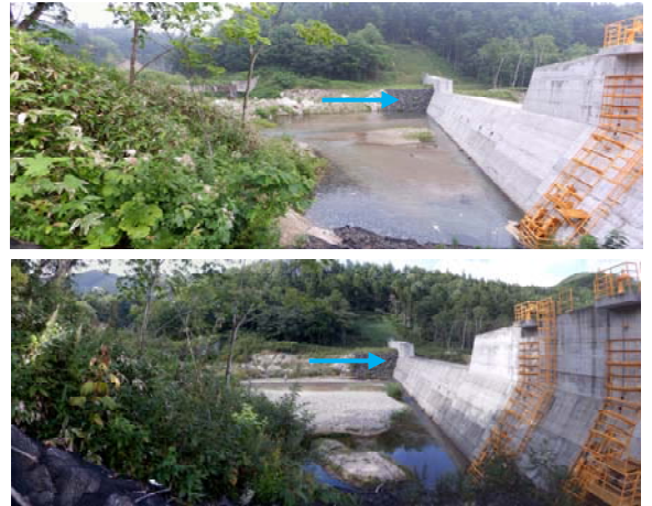
図6 1号砂防堰堤堆砂状況（上2022.7 下2023.9）
